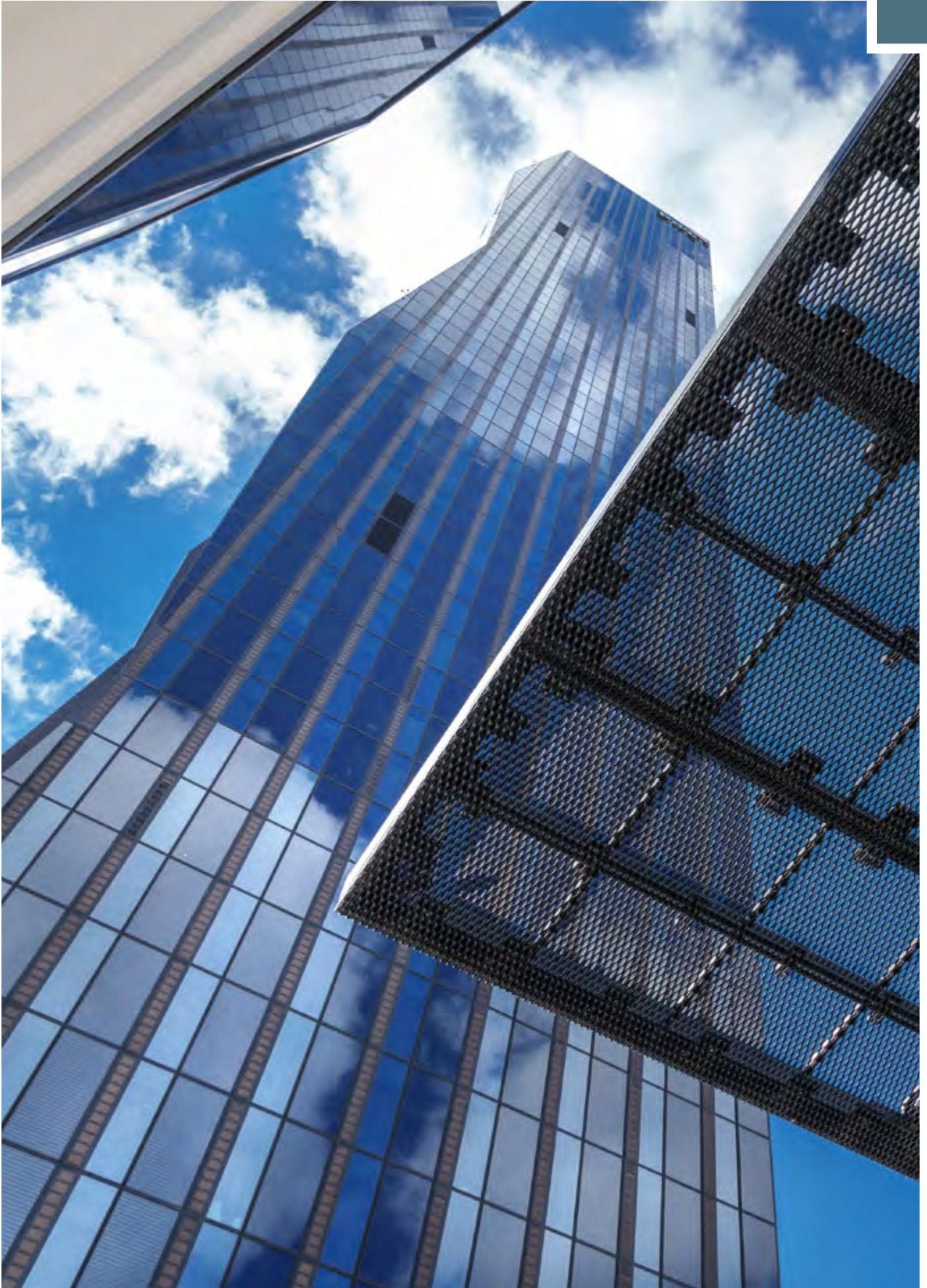
Wien, „DC Tower“
