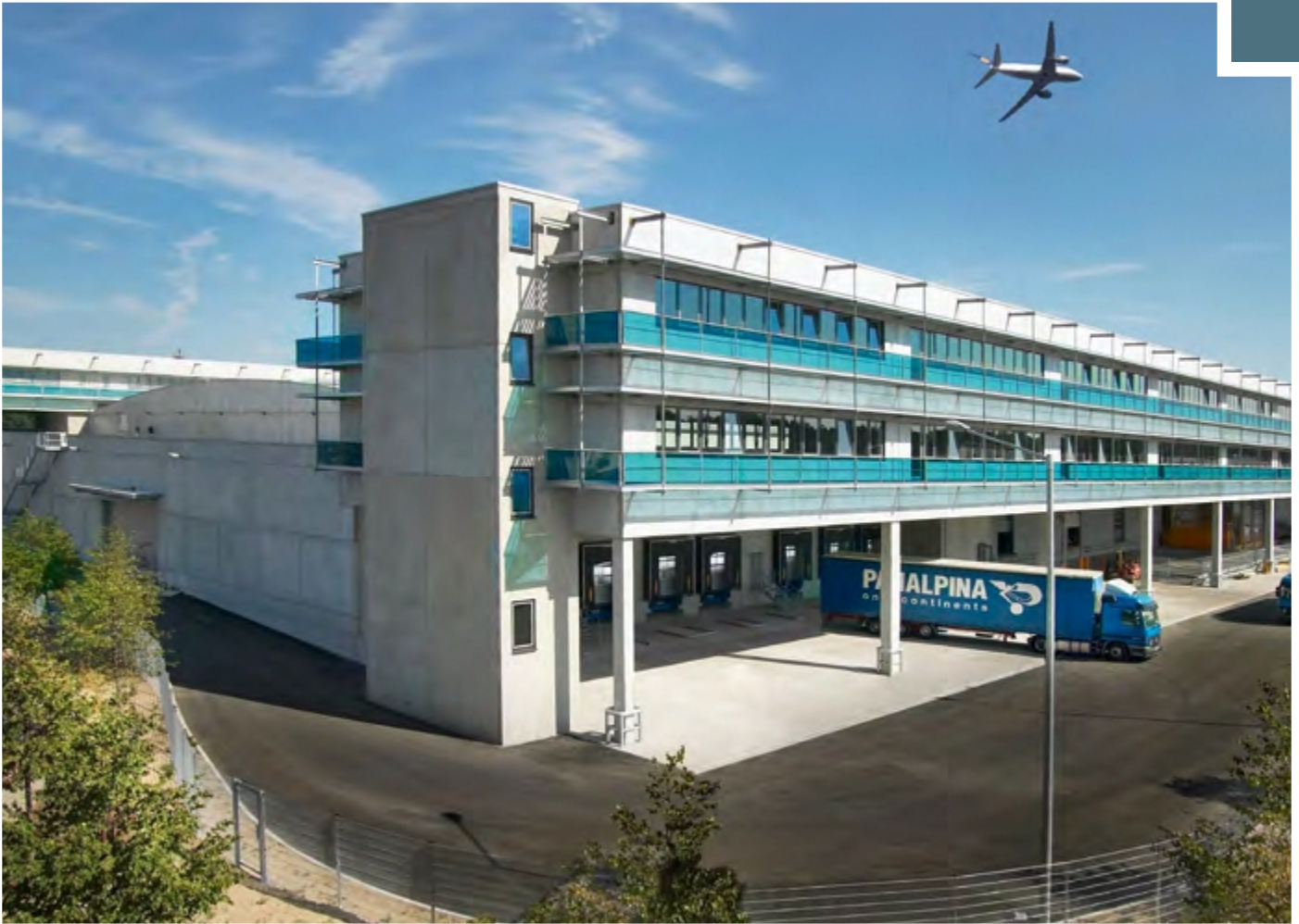
Frankfurt am Main, „AIR CARGO Center“
