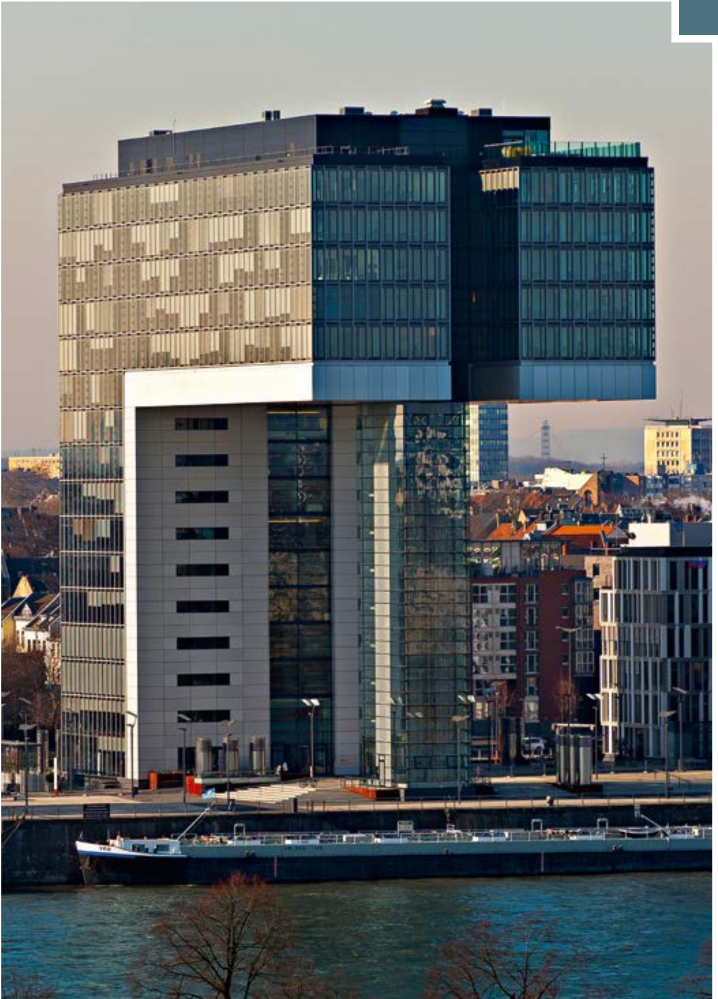
Köln, „Kranhaus Süd“
