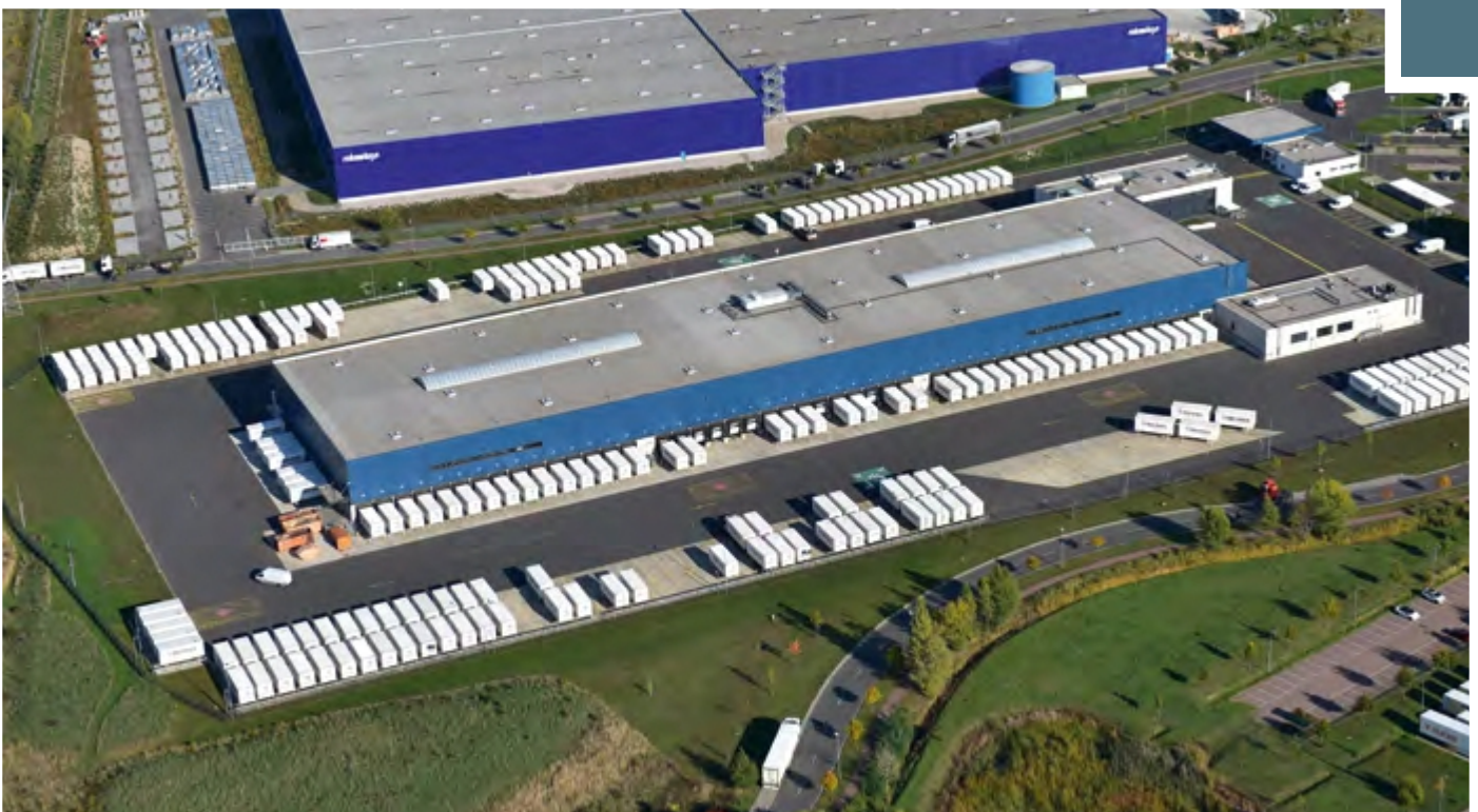
Kabelsketal OT Großkugel, „Logistik-Center Halle-Grosskugel“
