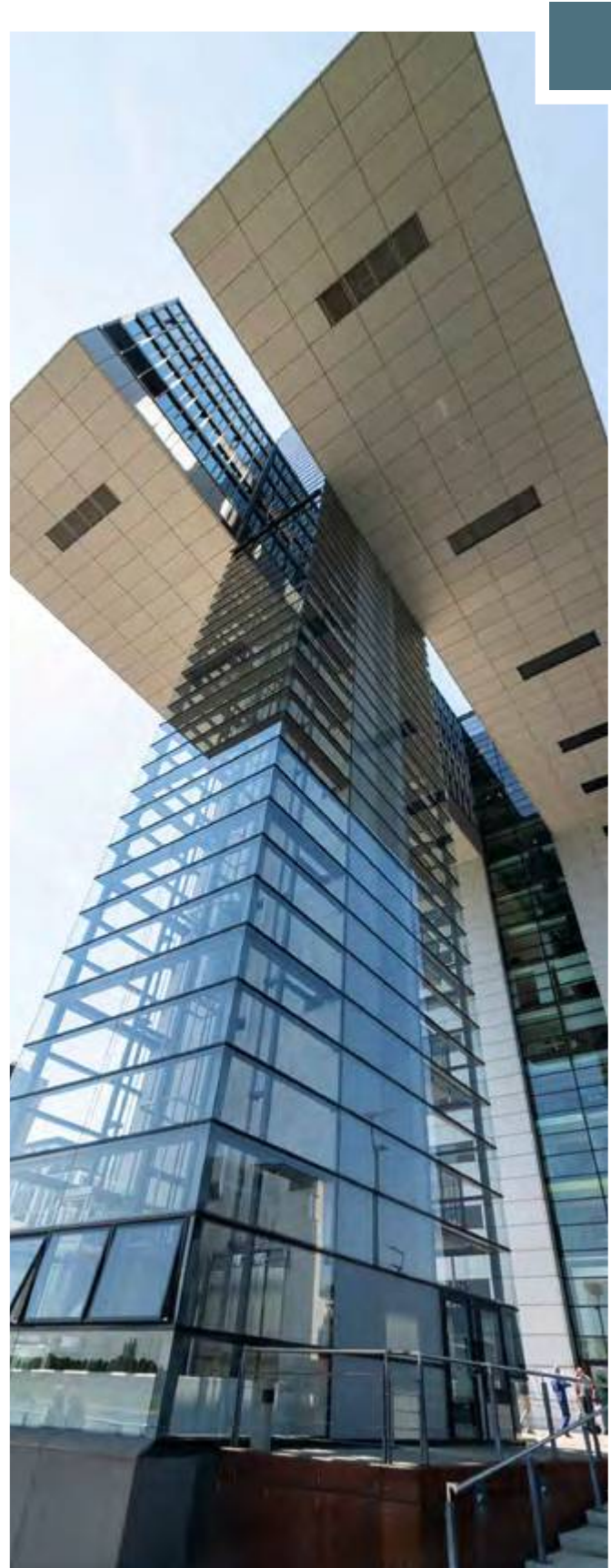
Köln, Im Zollhafen 18, „Kranhaus Mitte“
