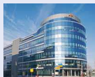
Besitzübergang: September 2016 Espace Petrusse, Luxemburg
