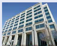
Besitzübergang: April 2013 Midtown I & II, Atlanta, USA
