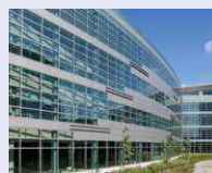
Besitzübergang: Oktober 2014, Bell Canada Campus, Phase I, Verdun/ Montréal, Kanada
