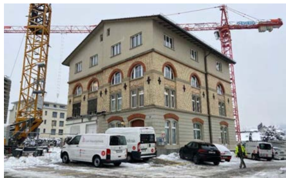
St. Gallen SG, Rorschacherstrasse 220
